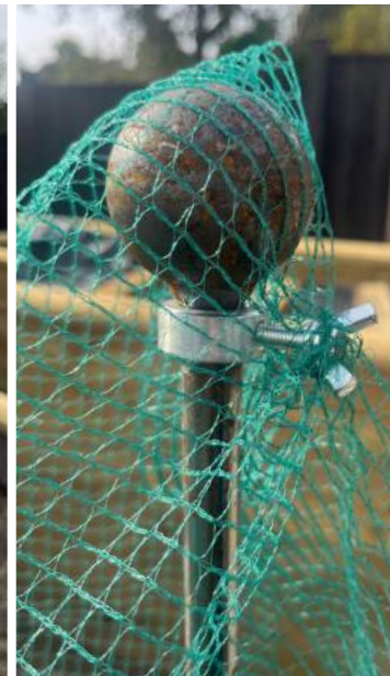
Placer ringene, og monter nettet – vikl nettet rundt om vingeskruerne, og stram skruerne i ringene øverst og nederst.
